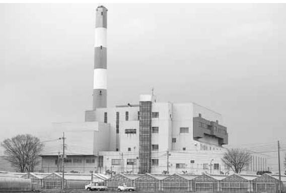
▲南部クリーンセンター
