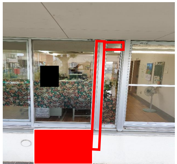
室外機設置場所
