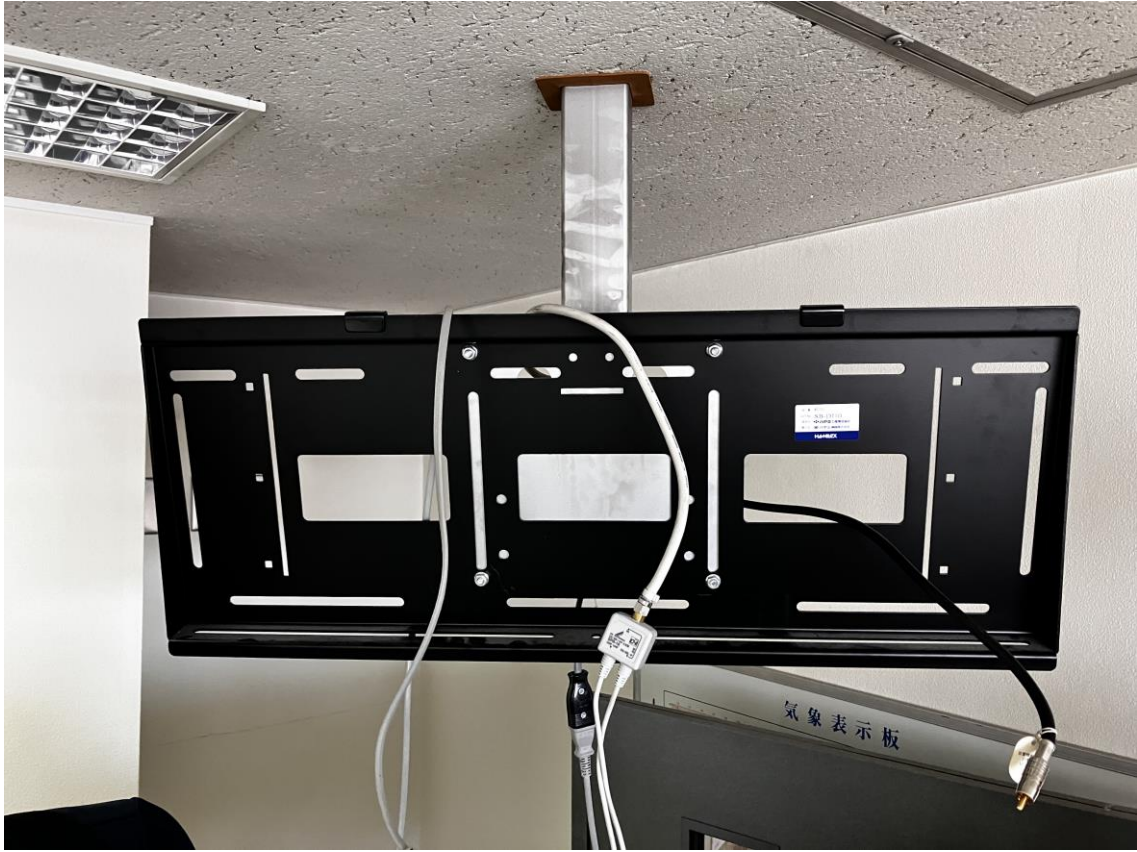
天井吊下げ金具全景
