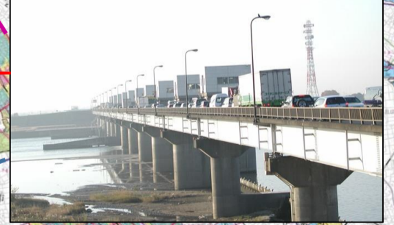
県道足利邑楽行田線 利根大堰（北）
