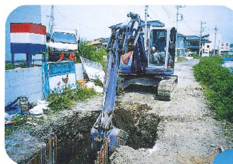
△下水道築造工事
