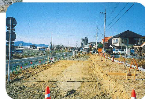
△道路築造工事
