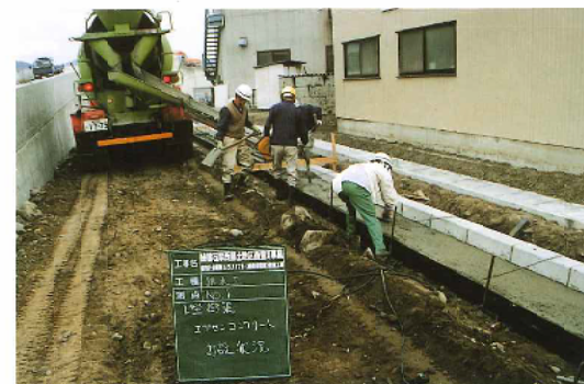
△ 道 路 築 造 工 事
