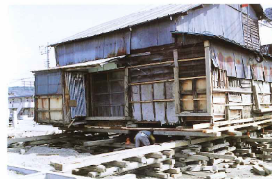
△ 建 物 移 転 工 事
