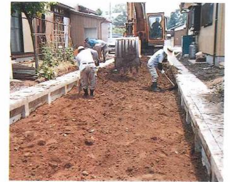
△ 道路築造工事
