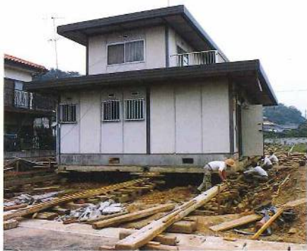
△ 建物移転工事
