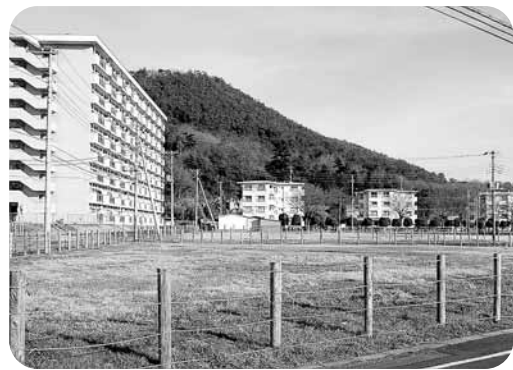
▲春日市営住宅(山下町)
