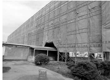
▲愛宕台中学校の耐震補強工事
