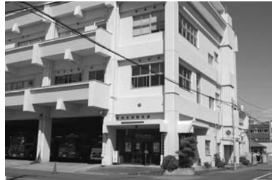
▲消防本部庁舎
