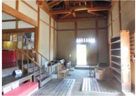
復元された庫裡土間の状況
