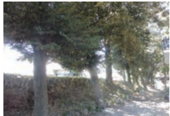
西側土塁の樹木繁茂状況
