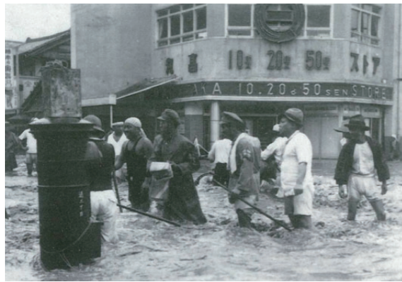
商店街に氾濫した洪水の中を歩く人々(通2丁目)
