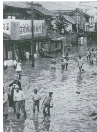
浸水した街中を歩く人々(市内)
