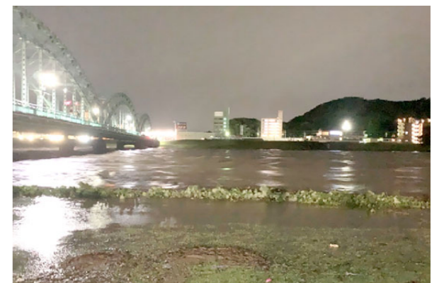
渡良瀬川中橋付近の増水
