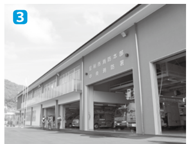
消防本部新庁舎
