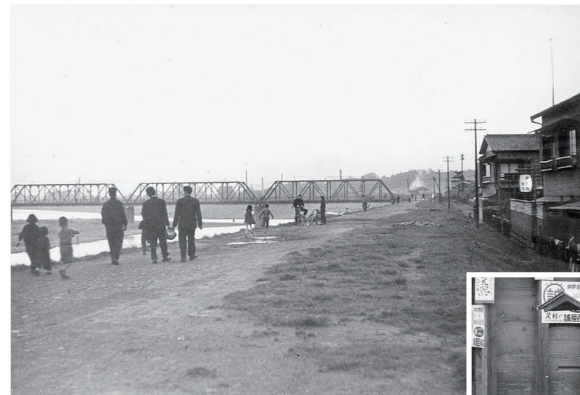
▲昭和31年・渡良瀬橋付近の堤防。
