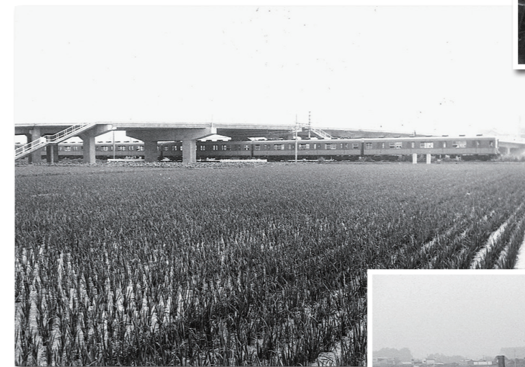
◀昭和47年4月・開通した朝倉跨線橋。
