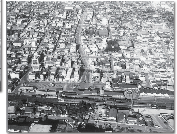
◀▼昭和46年5月・9年間にわたる駅前土地区画整理事業が竣工した。
