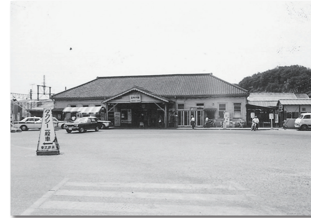
▼高架になる前の足利市駅。
