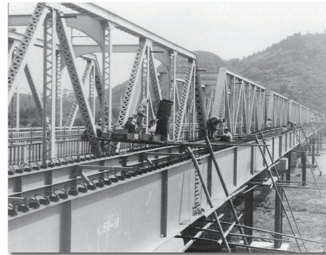
▼昭和39年3月に開通した渡良瀬橋沿いの歩道橋工事。
