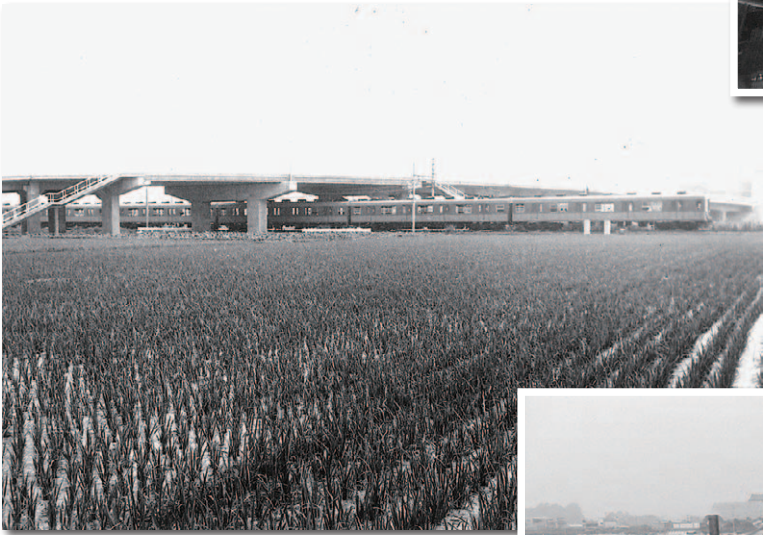
◀昭和47年4月・開通した朝倉跨線橋。
