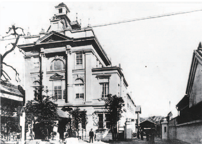
▼昭和35年の織物会館。現在の織物会館は、昭和43年3月に開館した。
