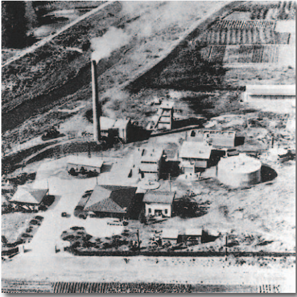
◀昭和33年11月・完成した山川し尿処理場。
