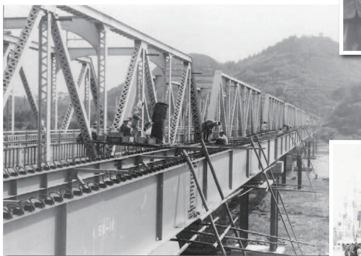
▼昭和39年3月に開通した渡良瀬橋沿いの歩道橋工事。
