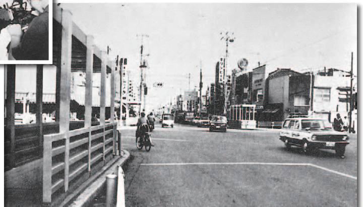
▶昭和46年4月・市内で初めての地下道が昭和通りにつくられた。
