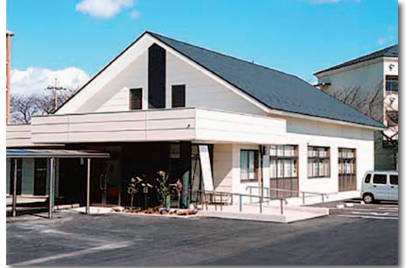
▼平成17年4月・山辺公民館ホール棟が完成した。
