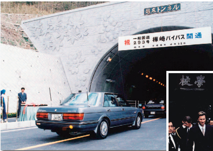
◀平成8年・開通した越床トンネル。
