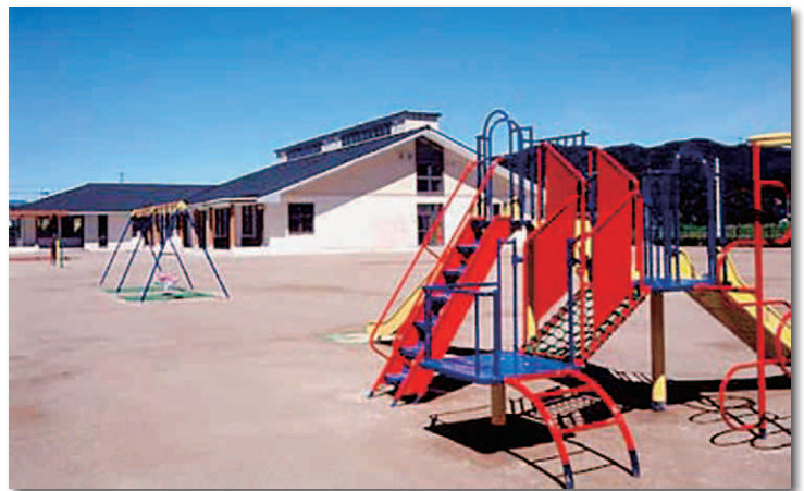
▲平成17年4月・にし保育所が完成した。
