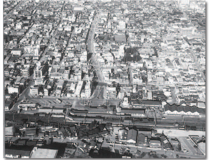
◀▼昭和46年5月・9年間にわたる駅前土地区画整理事業が竣工した。
