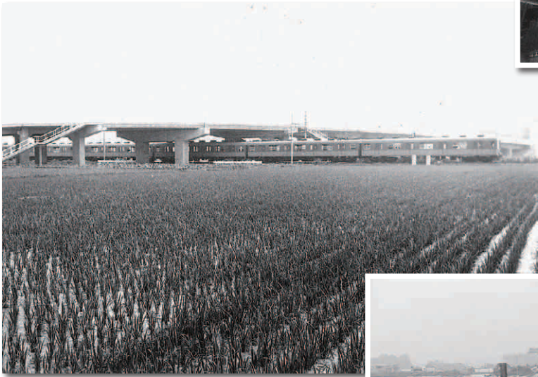
◀昭和47年4月・開通した朝倉跨線橋。
