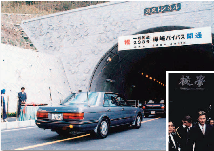
◀平成8年・開通した越床トンネル。
