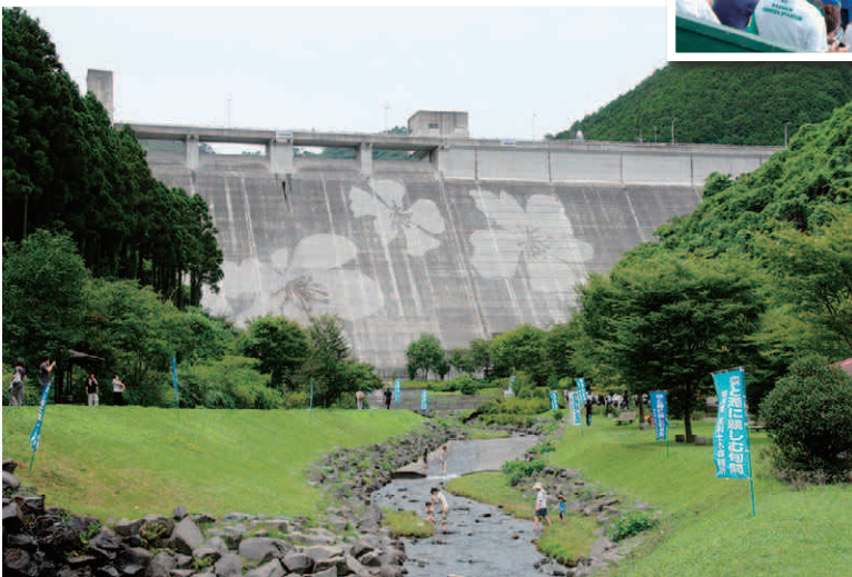
▼平成20年7月・松田川ダムのエコアート。
