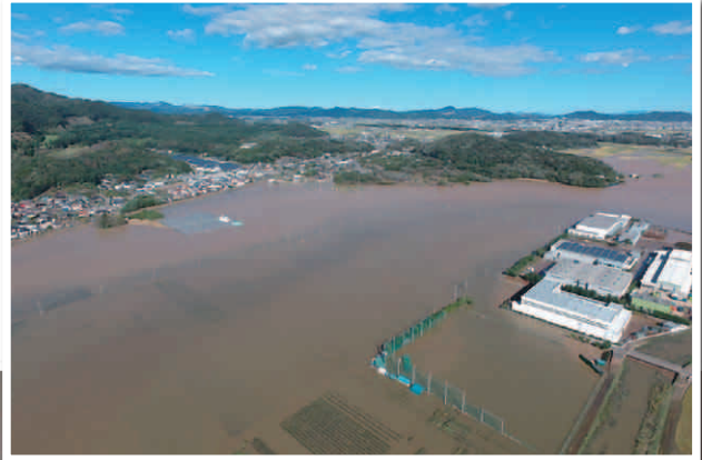
▼ 令和元年東日本台風の被害の様子。
