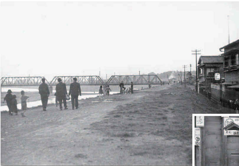
▲昭和31年・渡良瀬橋付近の堤防。
