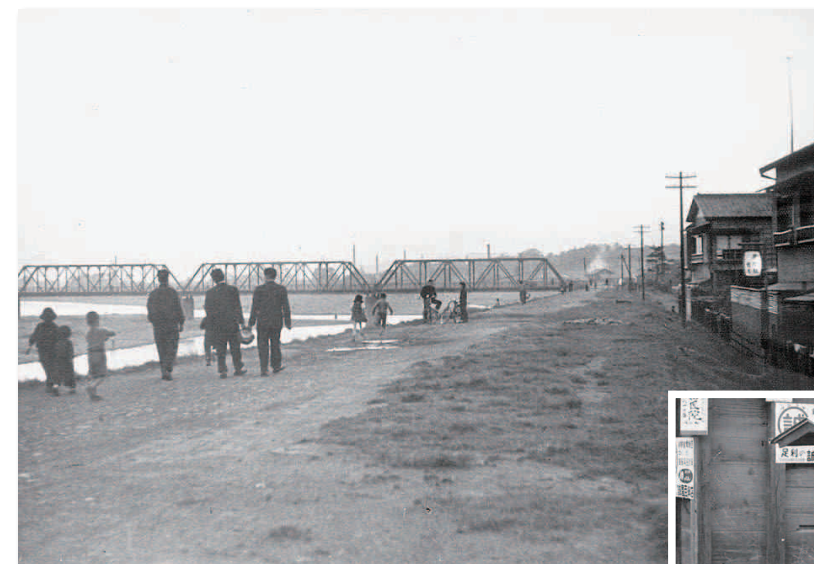
▲昭和31年・渡良瀬橋付近の堤防。
