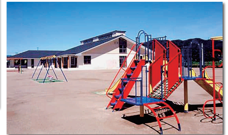
▲平成17年4月・にし保育所が完成した。
