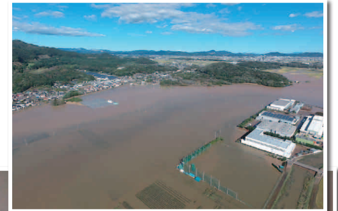
▼令和元年東日本台風の被害の様子。
