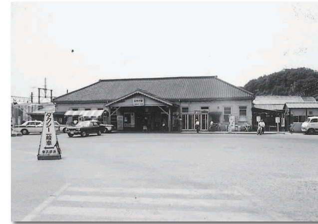
▼高架になる前の足利市駅。
