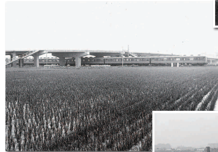
◀昭和47年4月・開通した朝倉跨線橋。
