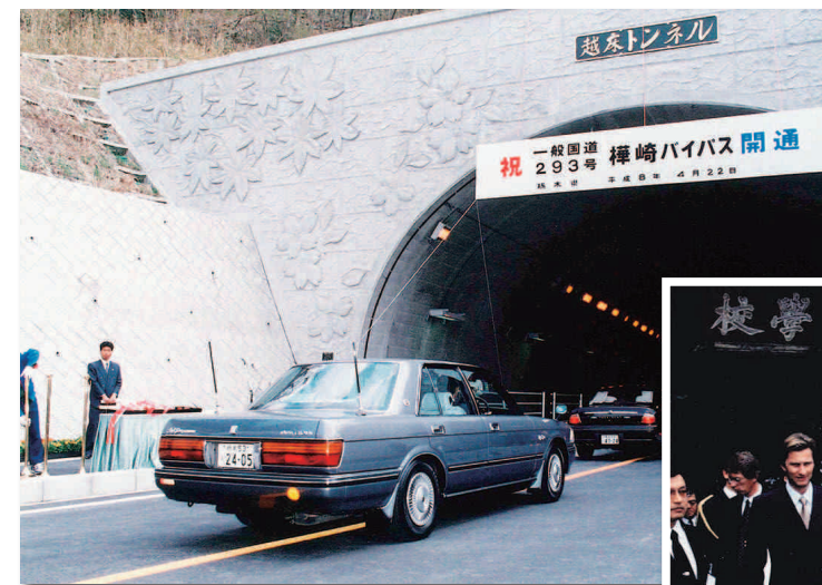
◀平成8年・開通した越床トンネル。
