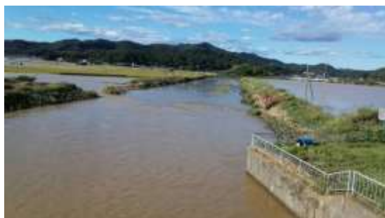
決壊した出流川(寺岡町)
