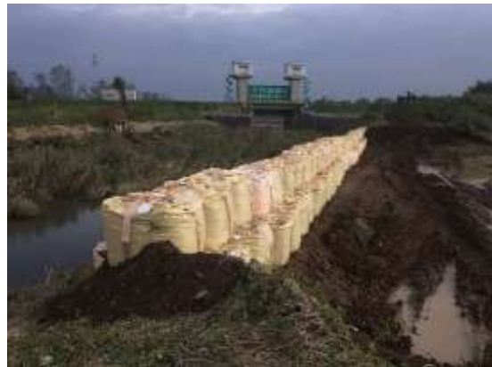
奥戸町 出流川の破堤仮復旧
