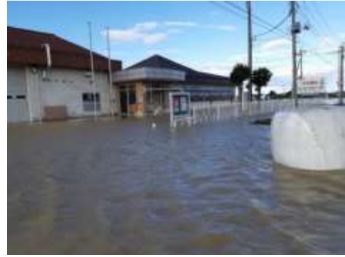
毛野東部工業団地、東分署の冠水
