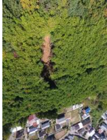
本城一 土砂災害現場
