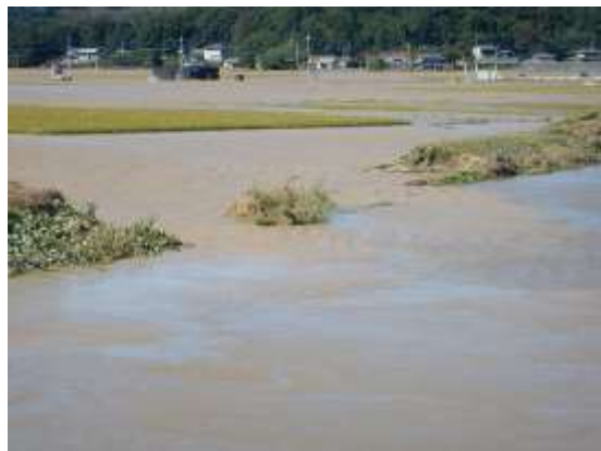
奥戸町 出流川の破堤箇所
