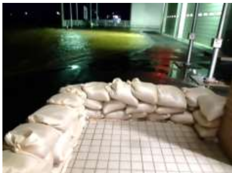
東分署における土のう積み
