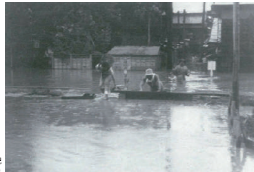
浸水状況(通6丁目付近)
