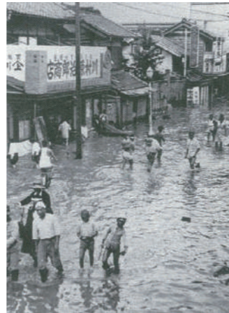
浸水した街中を歩く人々(市内)
