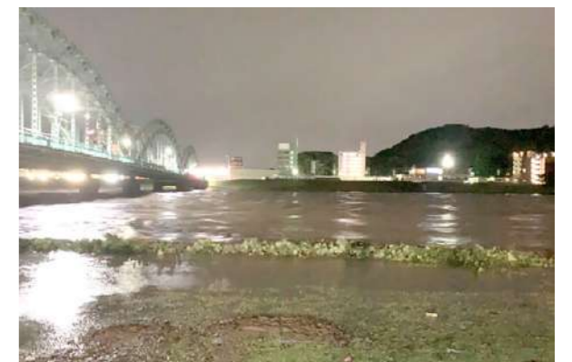
渡良瀬川中橋付近の増水
