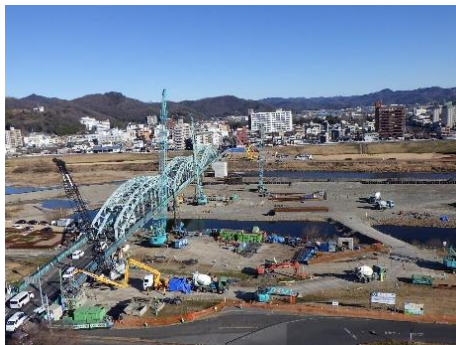
▲架け替え工事が進む中橋
