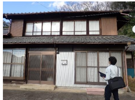
▲空き家バンク物件の調査状況
