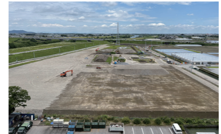
▲造成工事が進む新たなごみ処理施設の建設用地
