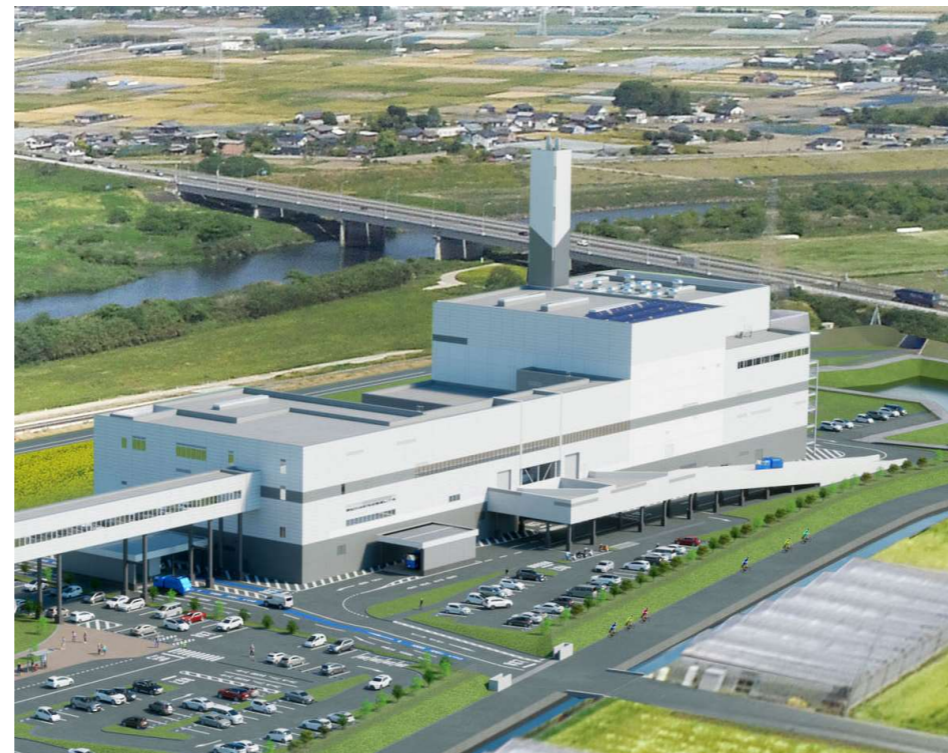
南西側からの外観(一般廃棄物処理施設)
