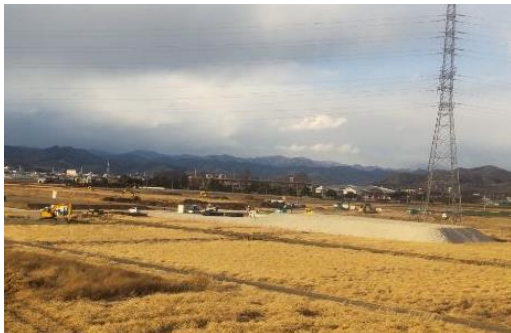
▲造成が進む(仮称)あがた駅北産業団地
