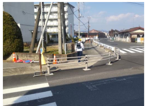
▲安全に整備された通学路
