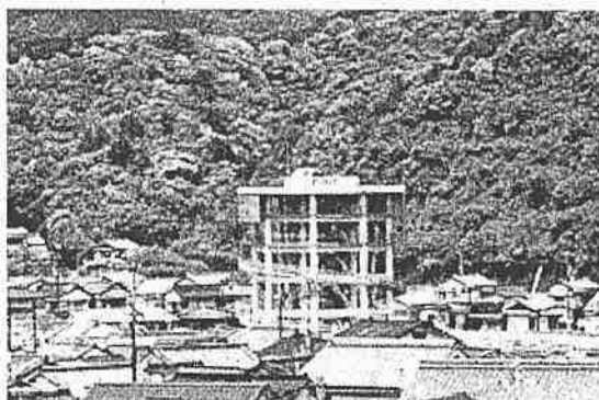
津波避難タワー
