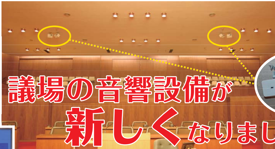
傍聴席用に新たに 設置したスピーカー (4台)
