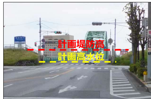
中橋と渡良瀬川堤防の状況(通二丁目側)
