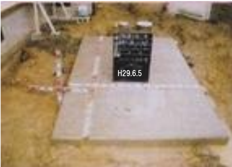
⑬ 上部スラブコンクリート打設
