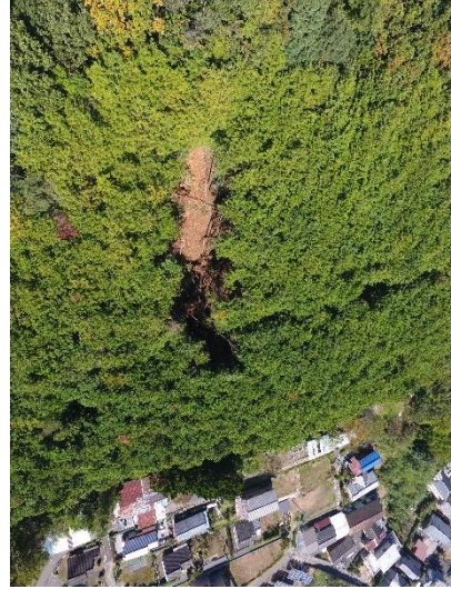
本城一 土砂災害現場
