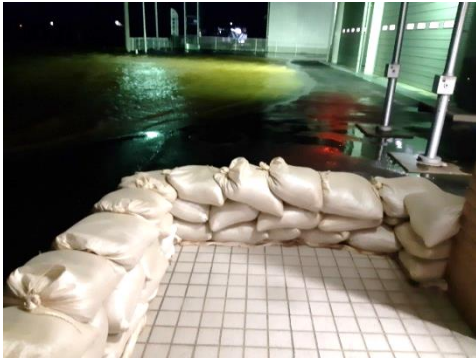
東分署における土のう積み
