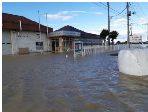
毛野東部工業団地、東分署の冠水
