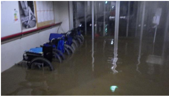
老人保健施設内の浸水
