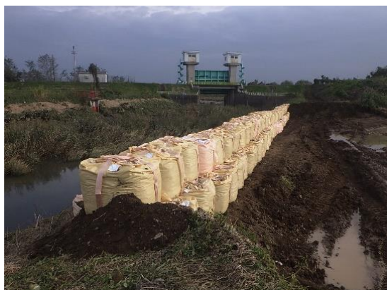
奥戸町 出流川の破堤仮復旧
