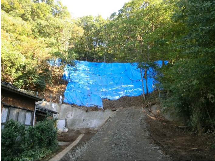
助戸大橋町 土砂災害現場
