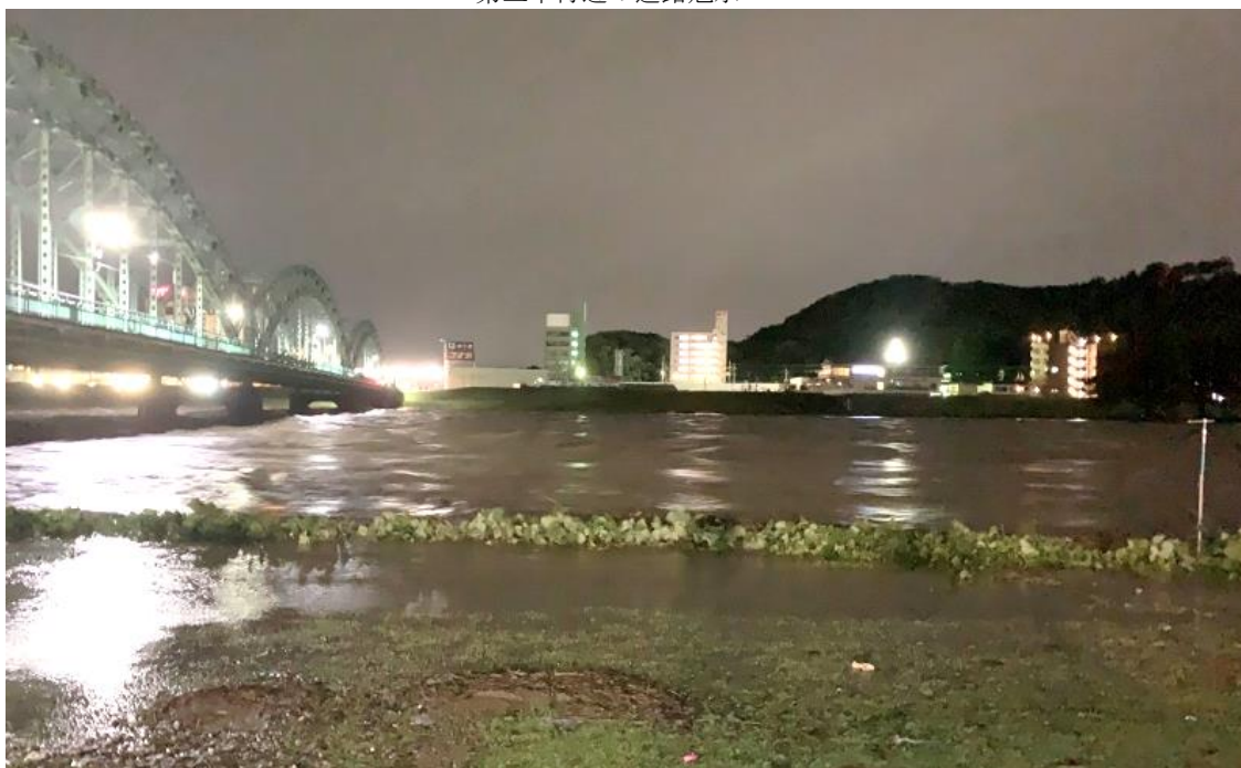
渡良瀬川中橋付近の増水
