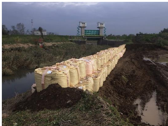
奥戸町 出流川の破堤仮復旧
