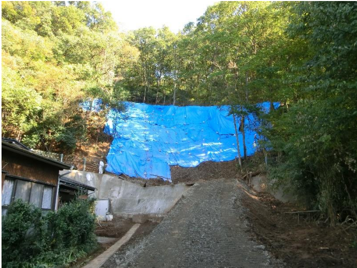
助戸大橋町 土砂災害現場
