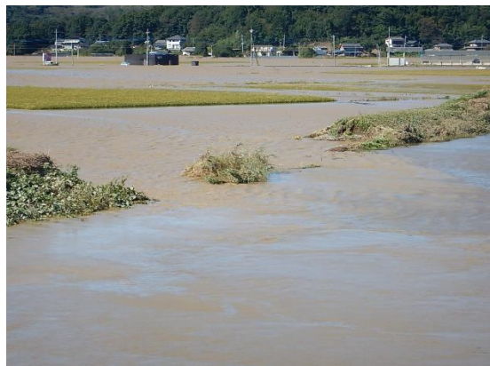
奥戸町 出流川の破堤箇所
