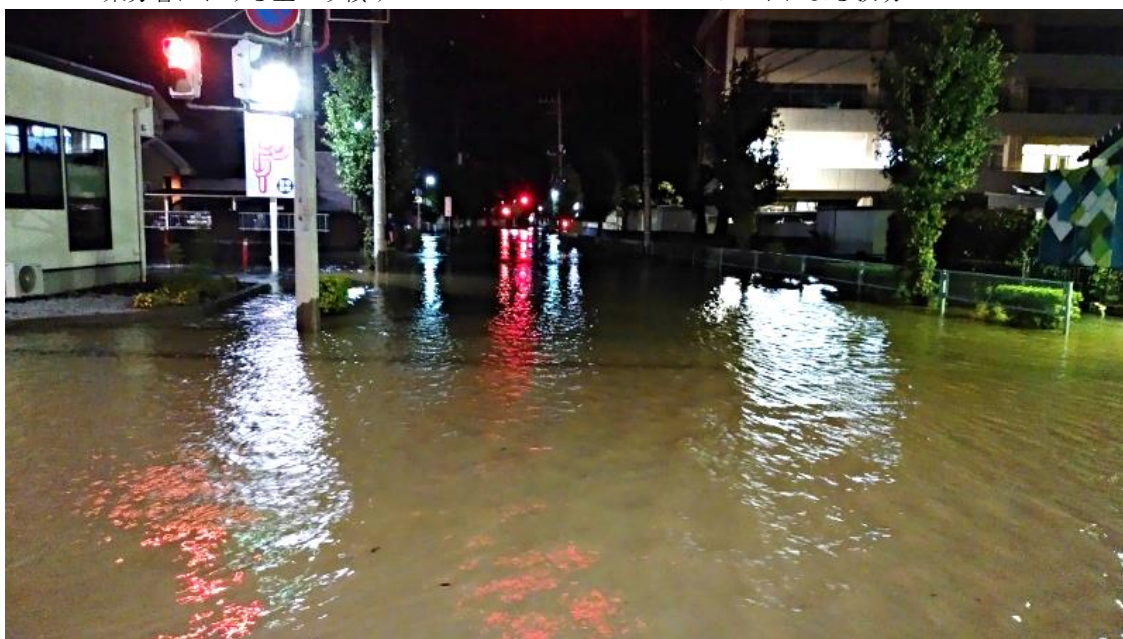
第三中付近の道路冠水
