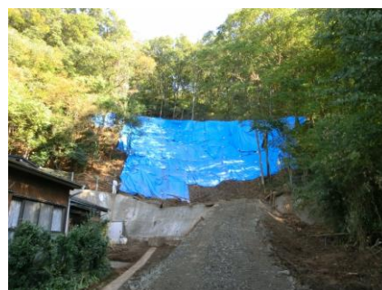
土砂災害箇所(助戸大橋町)
