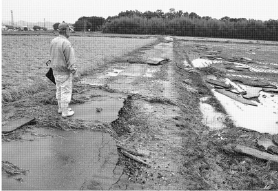
アスファルトがはがされた稲岡町の農道。土砂などが農地に流れ込んだ
