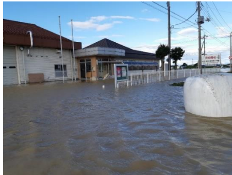
毛野東部工業団地、東分署の冠水
