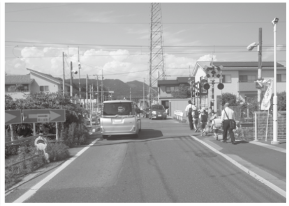
踏切の拡幅工事を実施する 五十部町4号線
