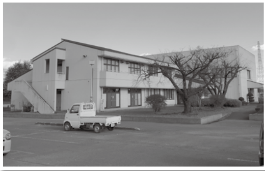
閉館した 農業研修センター
