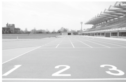
▲きれいに改修された陸上競技場走路
