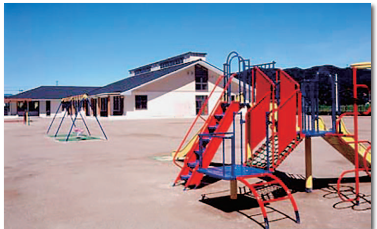
▲平成17年4月・にし保育所が完成した。
