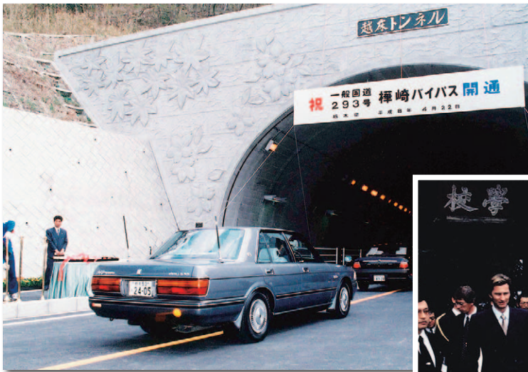
◀平成8年・開通した越床トンネル。
