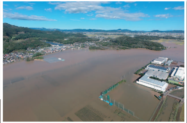
▼ 令和元年東日本台風の被害の様子。
