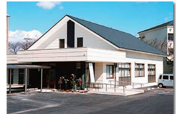
▼平成17年4月・山辺公民館ホール棟が完成した。
