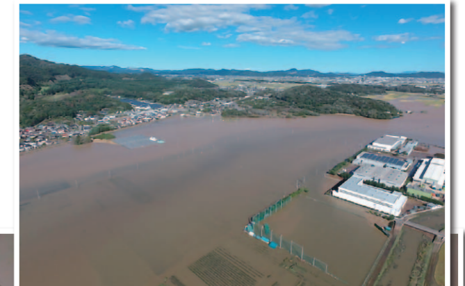
▼令和元年東日本台風の被害の様子。
