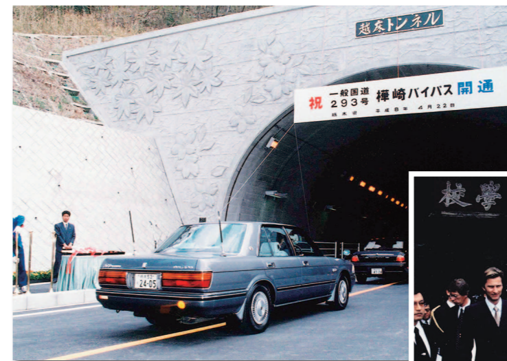
◀平成8年・開通した越床トンネル。
