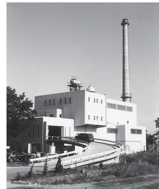
▼昭和51年9月・急増するごみに対応するため、西部清掃事業所が大前町に完成した。当時、ごみ焼却の余熱を利用したお湯が、隣接する西幸楽荘に供給されていた。
