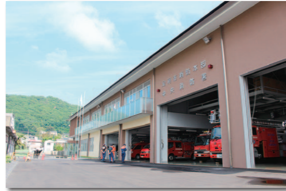
▲令和3年5月撮影・新消防庁舎・中央消防署。
