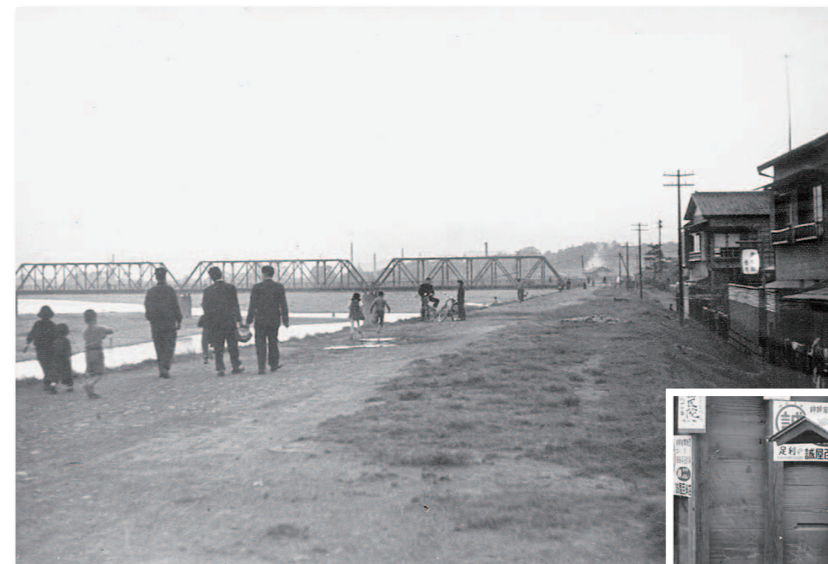
▲昭和31年・渡良瀬橋付近の堤防。
