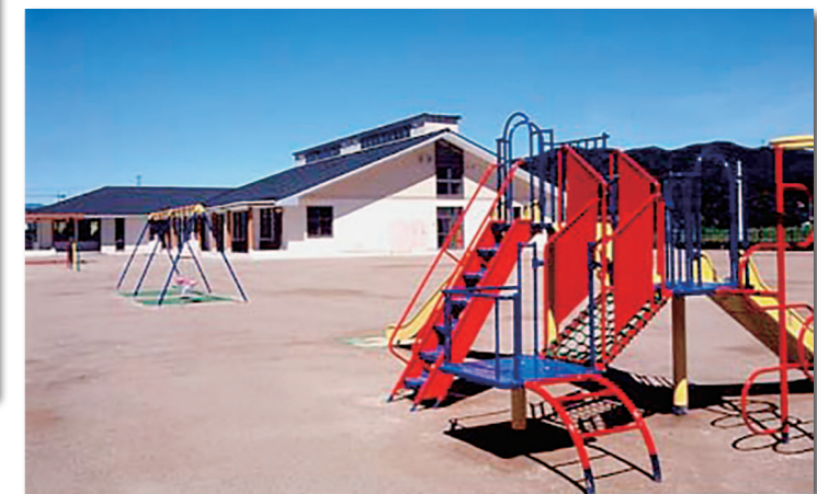
▲平成17年4月・にし保育所が完成した。
