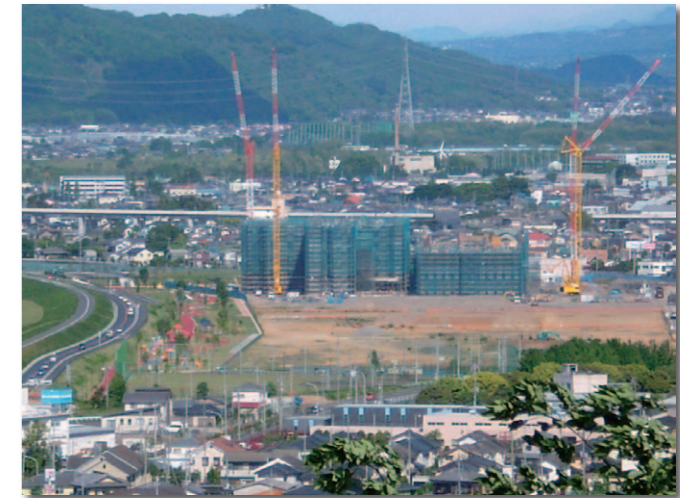
▲平成22年5月・浅間山からの展望。日本赤十字病院の建設中の様子がうかがえる。
