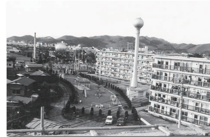
▼昭和50年2月・錦町市営住宅団地の造成が完了した。
