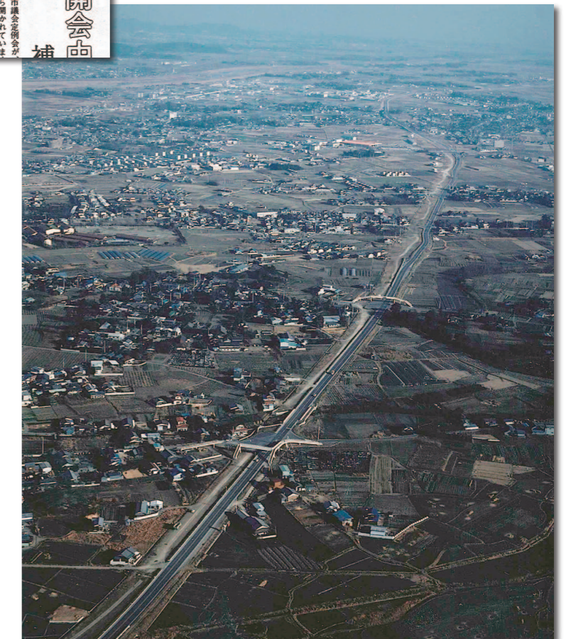
▼昭和50年12月・新国道50号(足利バイパス)が暫定2車線で全線開通した。
