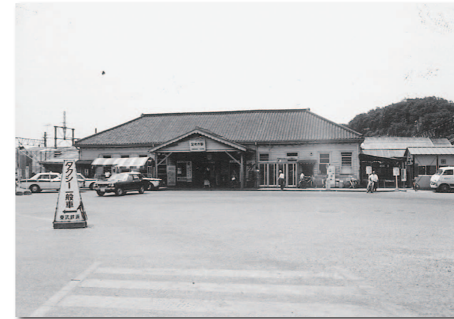
▼高架になる前の足利市駅。
