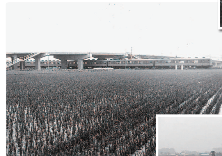
◀昭和47年4月・開通した朝倉跨線橋。
