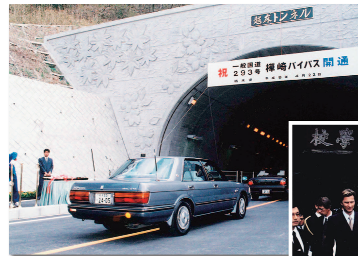
◀平成8年・開通した越床トンネル。
