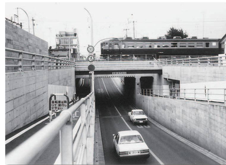
▼昭和54年11月・足利駅南土地区画整理事業の一環として、足利駅の東、伊勢町四丁目地内に、両毛線の下を南北に結ぶ『あずま地下道』が開通した。
