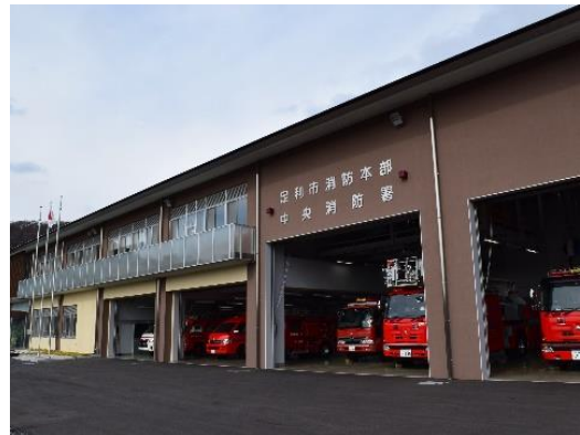
▼第2期工事が始まる 新消防本部庁舎
