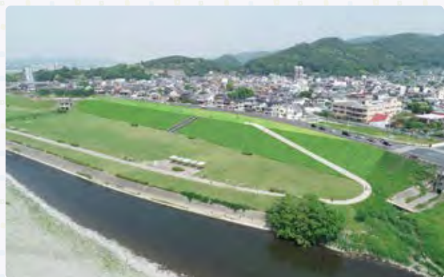
本町緑地完成イメージ (出典：国土交通省渡良瀬川河川事務所)
