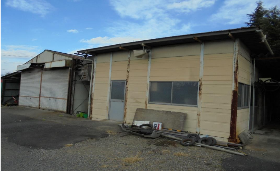
倉庫(建物西側)
