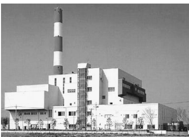
▲現在の南部クリーンセンター
