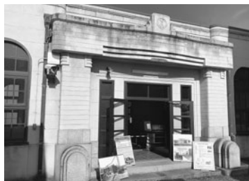
▲昭和5年建築の今福浄水場ポンプ室
