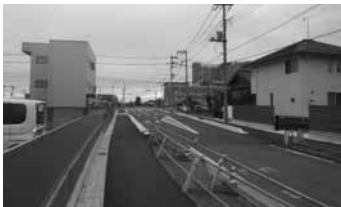
▲施工中の市道五十部町4号線
