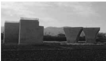
▲建設中の小俣立体交差
