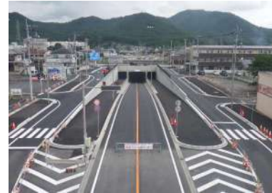
▲道路の整備・保全 (山前アンダー)
